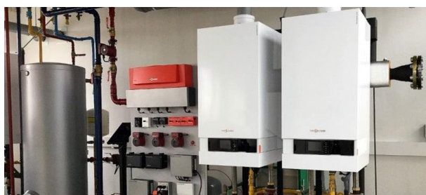
Montáž kotlov a celého vykurovacieho systému
